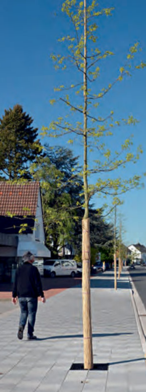
Abb. 2: Überbaute Pflanzgrube, Baum-scheibe: 50 Zentimeter Baumrost. Trennender Pflasterbelag und Baumrost machen dem Gärtner die Überwachung der Bodenfeuchte für die in der Etablierung wasserbedürftige Sumpfeiche ( Q. palustris , STU 30-35) unmöglich.
